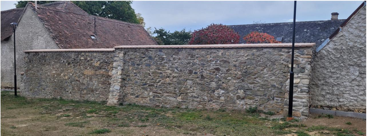
Oprava kamenné zdi byla provedena systematicky. Mirek Papoušek začal vystavěním chybějících pilířů, aby obnovil stabilitu celé konstrukce. Následně doplnil chybějící kameny, s respektem k původnímu designu, a provedl precizní vyspárování, což pomohlo obnovit nejen estetiku, ale i celkovou pevnost zdi. Pro
